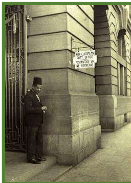
ENTREE SEGREGUEE POUR LES NON EUROPEENS DANS LE BATIMENT DES POSTES A PRETORIA.
